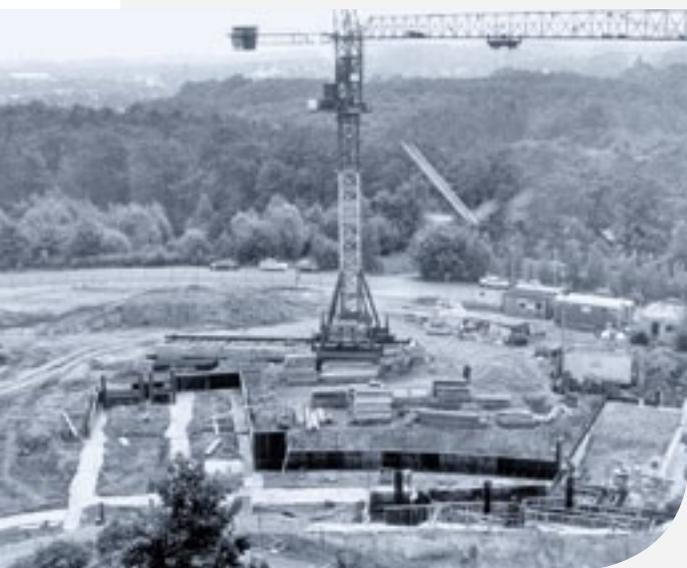
Die Fundamente für das Philipp-Reis-Gebäude, in das der Fachbereich Elektrotechnik einzog, wurden 1994 gegossen.
