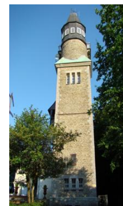
Danzturm (384,5 m/NN)- Windbergbewohner-Panoramio
