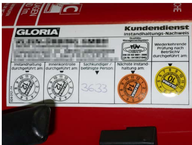
Auf den Feuerlöschern befinden sich Prüfplaketten.
