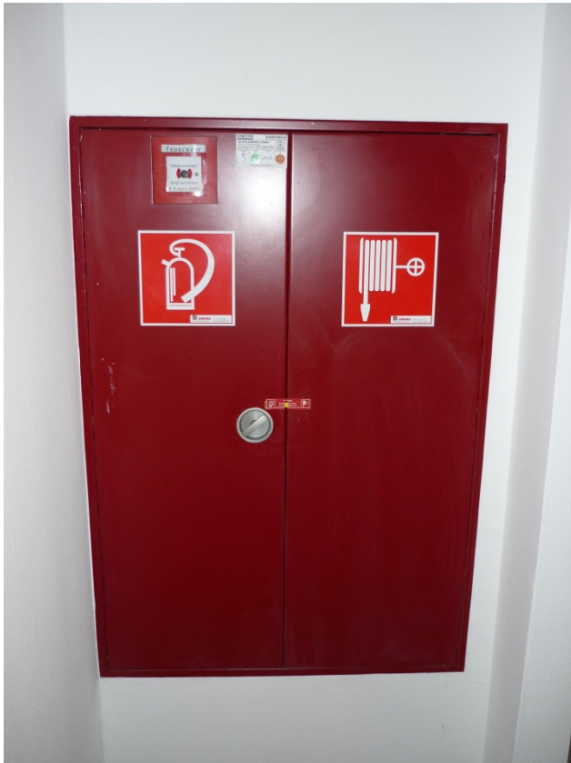
Beispiel für in einem Schrank untergebrachte Feuerlöscheinrichtungen (Feuerlöscher und Wandhydrant)
